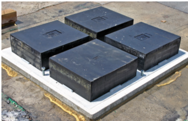
Bild 3. Auflagerpunkt mit 4 Elastomerlagern Fig. 3. Bearing with 4 elastomeric springs
