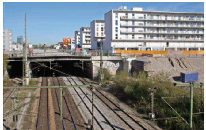
Bild 1. Neue Wohngebäude neben der Bahnlinie München-Rosenheim
