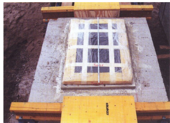
Justierung der Gleitlager auf Pfahlkopf
