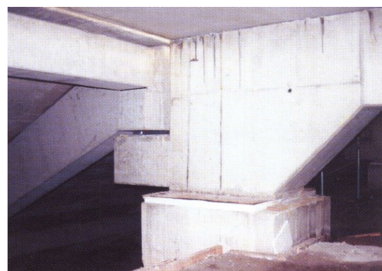
Einbausituation im fertigen Zustand
